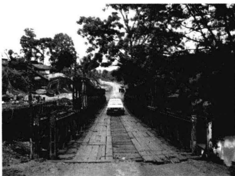
距缅甸105码处的旧桥
